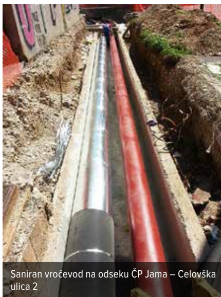
Poškodovani deli vročevoda na odseku ČP Jama – Celovška ulica 2
