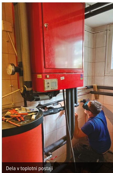
Zavarovanje armatur proti odpiranju med deli na parovodu
