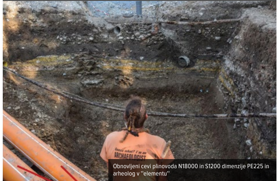
Obnovljeni cevi srednjetačnega in nizekotlačnega plinovoda
