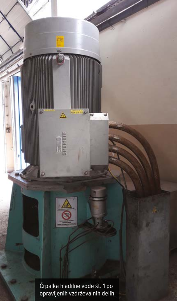
Remontno-vzdrževalna dela na 6.3 kV elektromotorju
