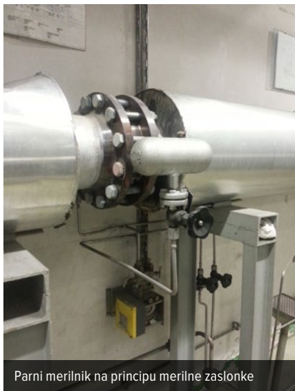
Izvajanje kontrole in meritev merilnega noža
