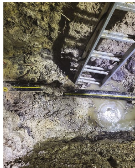
Sanacijo poškodovane plinske cevi je oteževalo zalitje jame s podtalnico.
