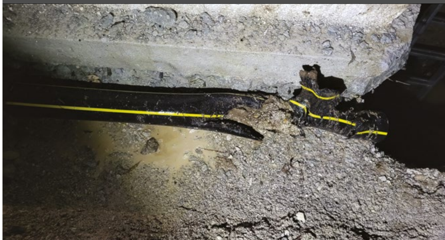
Sanacijo poškodovane plinske cevi je oteževalo zalitje jame s podtalnico.
