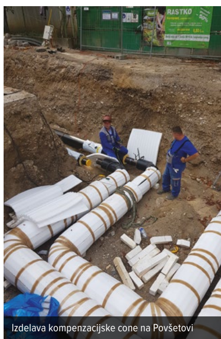
Navezava objekta Schellenburg na vročevodno omrežje
