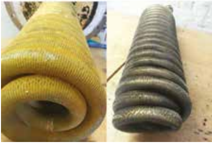
Slika 5: Fotografija zamenjave cevnega prenosnika toplote
